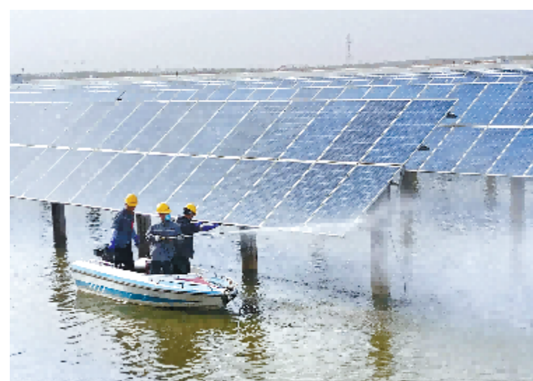
通威宁夏贺兰“渔光一体”电站运维团队清洗组件
